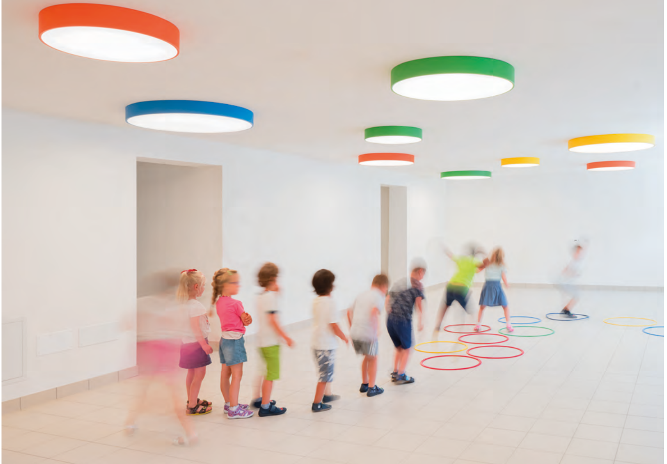
Ceiling lamps / Iluminación de techo
